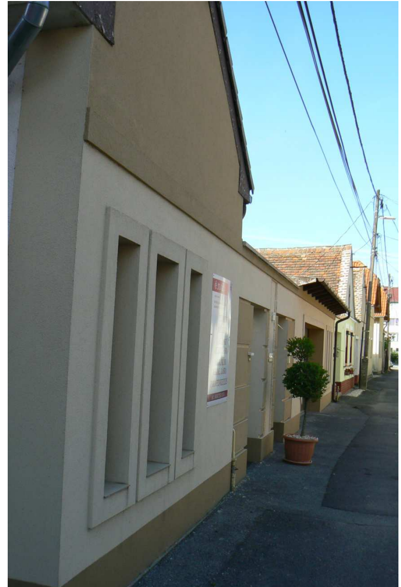
foghíjbeépítés a Tüskevár utcában
