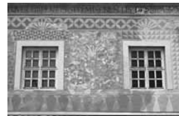
12. kép: A Jurisics tér 7. szám homlokzatának részlete (A tér épületeit a szerző fotózta, 2015)
