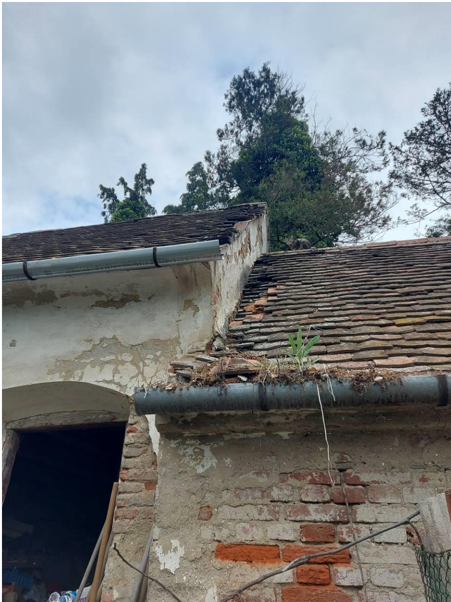
A volt istálló falszerkezete elkülönül az alapincézett épületrésztől.
