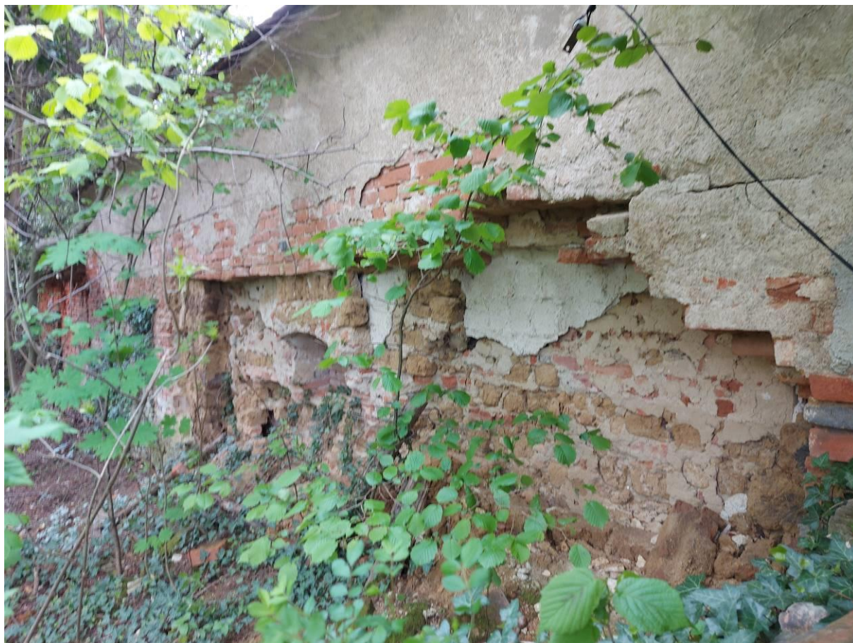
A melléképület északi falszerkezete
